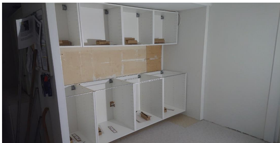
Köket är under renovering med nya skåp.
